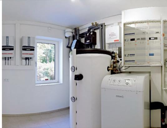
Im Abstellraum zwischen Garage und Haus befindet sich die Haustechnik. Die Wärmepumpe und die Lüftungsanlage mit Wärmerückgewinnung werden mit dem auf dem Dach produzierten Sonnenstrom betrieben. Der 500 Liter fassende Warmwasserspeicher dient als „thermische Batterie“.
