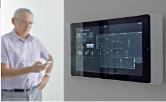
Gesteuert und überwacht wird die Haus- und Energietechnik über ein Bus-System. Der große Bildschirm im Erdgeschoss bietet einen Überblick über die Energieerträge der Photovoltaikanlage und die Verbräuche im Haus.
