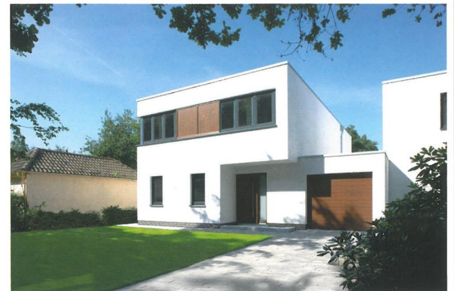
Effizienzhaus Plus, Bremen-Oberneuland: Das Musterhaus verfügt nicht nur über ein attraktives Äußeres, sondern auch über ein ausgeklügeltes Energiekonzept: Die optimal gedämmte, dichte Gebäudehülle und spezielle, dreifach verglaste Fenster vermeiden Wärmebrücken und -verluste. Hinzu kommen eine Erdwärmepumpe und eine Lüftungsanlage mit Wärmerückgewinnung. Das Ganze wird gesteuert durch modernste Gebäudeautomation. Abb.: HO Immobilien + Baukonzepte GmbH
